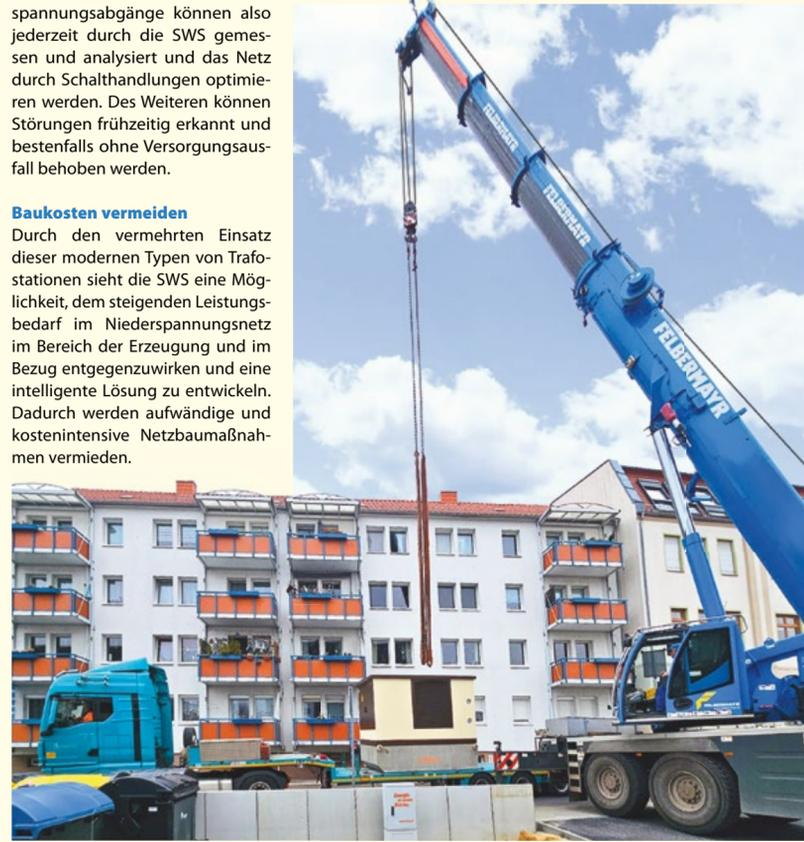
Für die Anlieferung der 13 Tonnen schweren Trafostation musste ein mobiler Kran positioniert werden und der Untergrund durch die Firma Ratthey exakt vorbereitet werden. Der Transport vom Hersteller aus Hoyerswerda musste mittels Tieflader geschehen.
