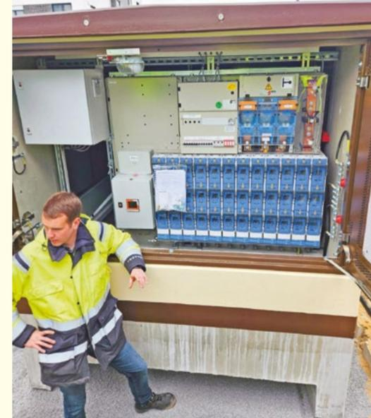
Trafostationen können als vollständiges elektrisches Gerät betrachtet werden. Im Inneren befinden sich alle Elemente eines Übertragungssystems, Transformator, Mittelspannungsschaltanlage, Niederspannungsschaltanlage und Messsysteme.
