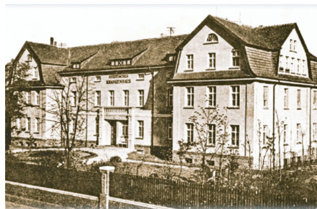
Eine historische Ansicht des Krankenhauses: Der Gebäudestrakt wird auch heute genutzt. Unter anderem befindet sich hier die Gynäkologische Praxis des MVZ.
