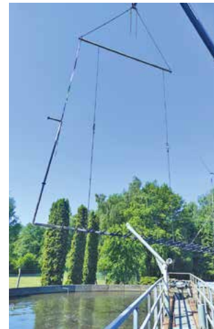
Per Kran werden die Belüftungsstränge aus dem Becken und später wieder zurück ins Abwasser gehoben.
