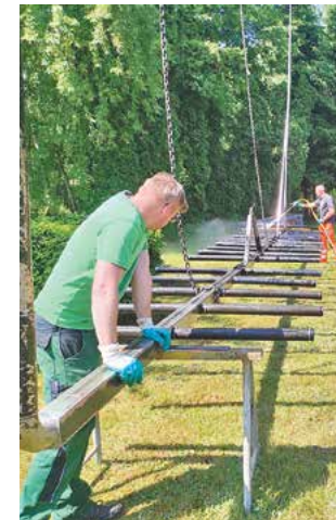
Ein Belüftungsstrang hat 40 Lüfterkerzen, die jeweils 75 cm lang sind. An Land werden sie einzeln gereinigt.
